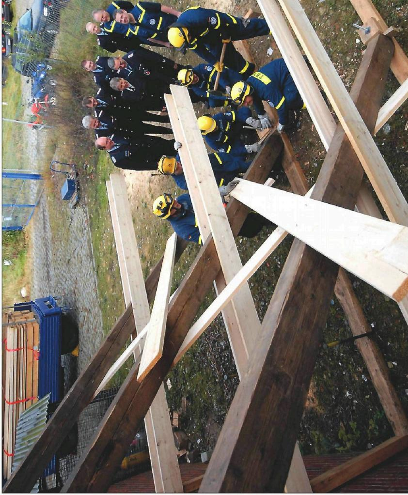
Um zu verhindern, dass eine Hauswand einstürzt, kann das THW einen Stützbock aufbauen. Vertreter von Polizei und Feuerwehr sehen sich den Aufbau der Holzkonstruktion ganz genau an. Foto: be
