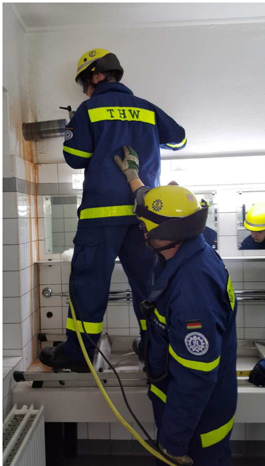
Kernbohrgerät im Einsatz für die Flüchtlingshilfe
