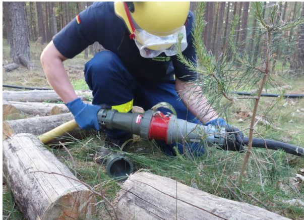
Helfer der 1. Bergungsgruppe verlegen Starkstromleitungen während des Flächenbrandes bei Dachtmissen
