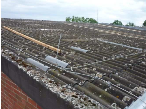
Dach dereinst und seit Mai; nicht zu erkennen: die erstmals verlegte Isolierschicht unter den Metallprofilen
